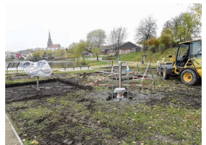
Nach langem Warten sind die Bauarbeiten für den neuen Bewegungsparcours nun im vollen Gange.
